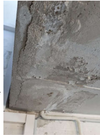
Carbonatisierung KG-Decke
