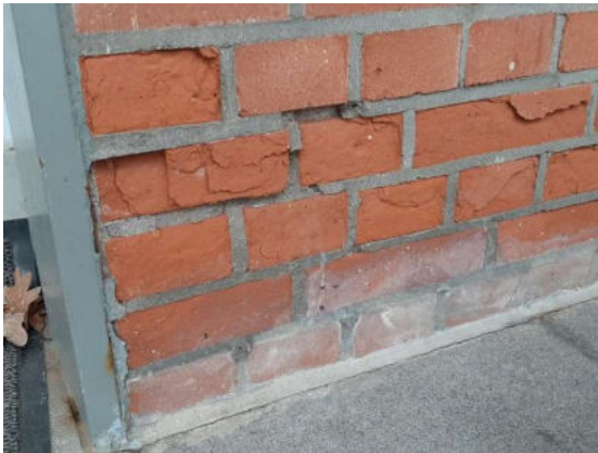
Frostschäden Gebäude
